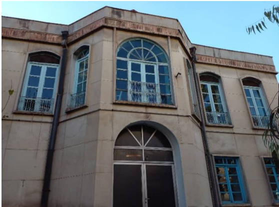
نمای اصلی بنای کنیسای تاریخی حئیم به همراه ورودی آن .
